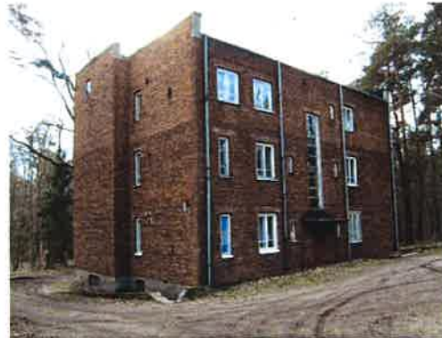
Fot. 42. Budynek mieszkalny sprzed 1939 r. na północ od (4c), widok z płn. wschodu.
