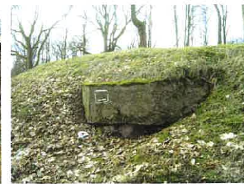
Fot. 32. Schron (3b), widok z płn. wschodu. Widoczne wieloboczne zakończenie i brak narożnego fragmentu ściany czołowej.
