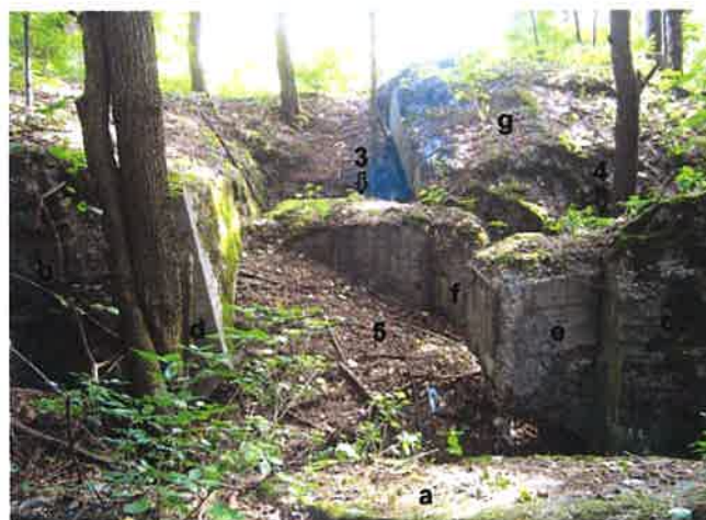
Fot. 23. Schron (2f), widok z płn. zachodu. Widoczny odrzucony do przodu fragment lewej ściany (a), miejsca oderwania tej ściany i orylonu (b, c), wnęka po płycie pancernej (d, e), zasypane częściowo wnętrze kazamaty (5), ściany oddzielające ją od pomieszczenia załogi (3) i obserwatora (4), do którego prowadzi przejście (f). Po lewej odchylona wybuchem ściana czołowa, po prawej w głębi część stropu (g).
