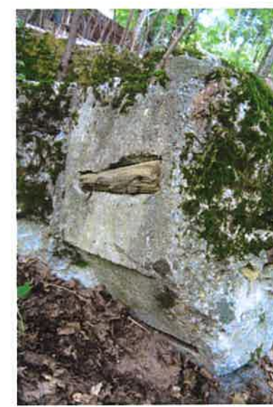
Fot. 15. Schron (2a) - policzek strzelnicy ckm z zachowaną listwą i rowek po drugiej listwie.
