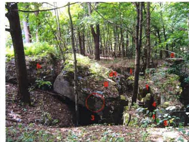
Fot.24. Schron (2f), widok z północnego wschodu. Widoczny układ wnętrza (oznaczenia za ryc. 18 i fot. 22), fragmenty stropu (g, h, i; kółkiem zaznaczone ocalałe kłamy), po prawej stronie zachowana część ściany lewej i skośny mur oporowy (c).
