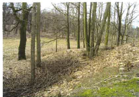
Fot. 35. Rów strzelecki w stoku kopca, biegnący od schronu (3c) i jego załamanie w kierunku głównej pozycji obronnej na zboczu w głębi. Widok od wschodu z górnej krawędzi kopca.
