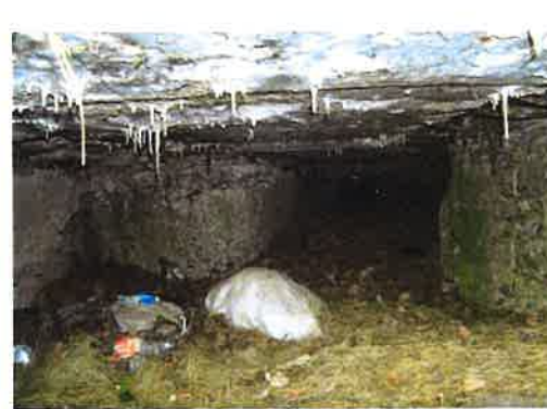
Fot. 31. Wnętrze schronu (3a) - częściowo zasypane, na wprost ściana wewnętrzna z przejściem do przedsionka.
