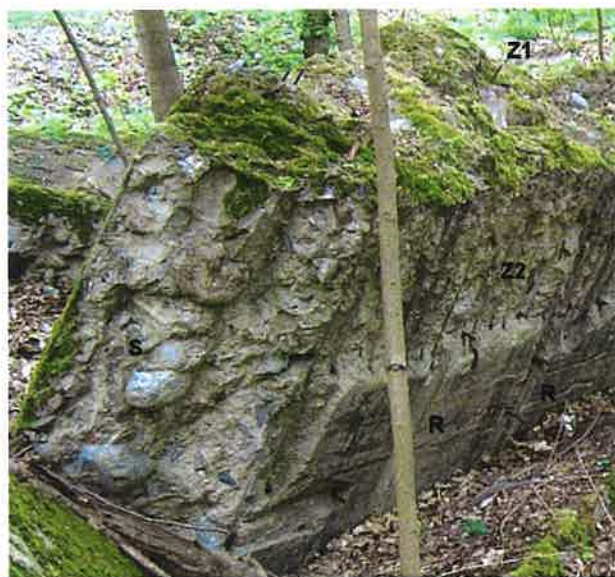
Fot. 13. Strop schronu (2a), widok z zachodu. Widoczne pręty zbrojenia z siatki górnej (Z1) i dolnej (Z2), dwa rowki (R) po listwach mocujących boazerie oraz odcisk szyny i górna warstwa betonu z otoczkami (S).
