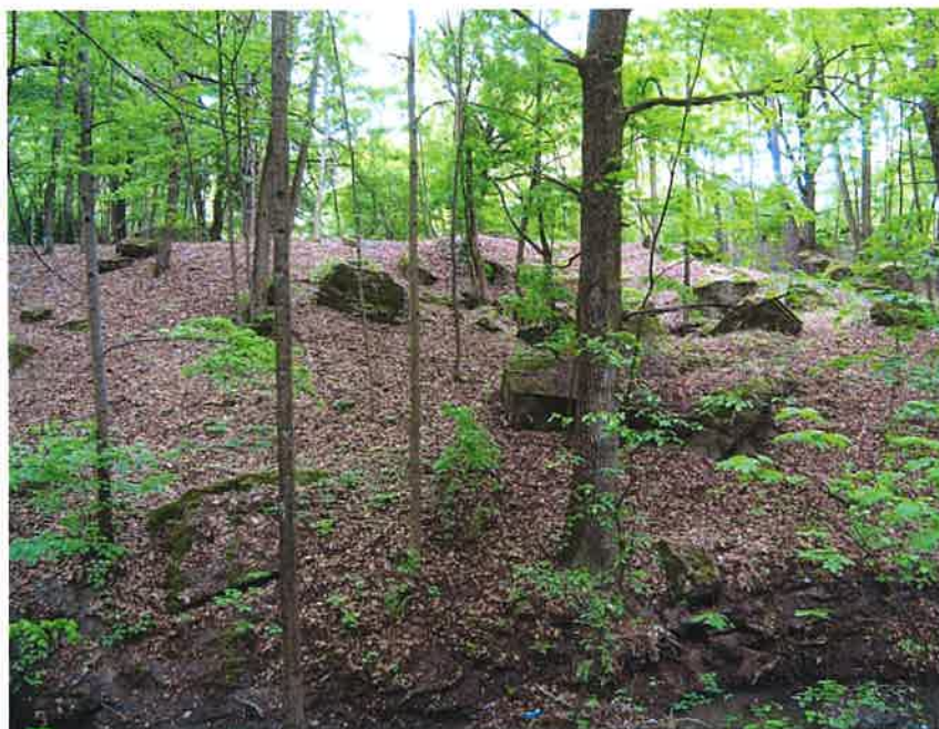
Fot. 20. Wysadzony schron bierny (2e) - widok od zachodu na rozrzucone wybuchem fragmenty sklepienia i tylnej ściany. U dołu kadru rów Kanału Boryszewskiego, na wprost za drzewem duży fragment tylnej ściany z murem oporowym z charakterystycznym schodkowym fundamentem, za nim zagłębienie z pozostałością schronu, na prawo od niego kolejne fragmenty tylnej ściany.
