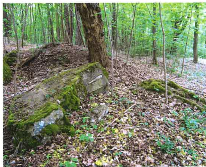
Fot. 14. Schron (2a) – przemieszczony wybuchem nasyp czołowy oraz leżący na nim fragment ściany czołowej z policzkiem strzelnicy ckm (z lewej, za nim strop i ściana lewa) oraz nadproże strzelnicy (z prawej). Widok z południowego wschodu.
